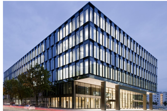
Bürogebäude ICADE Premier Haus, München
