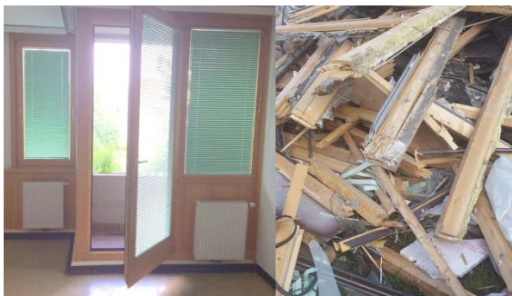
Abbildung 7: Fenster vor und nach Abbruch eines Gebäudes 18
